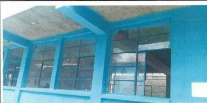
Foto 5: EN ESTA FOTO SE OBSERVA EL DETERIODO DE LOS VIDRIOS DE 6 AULAS.
