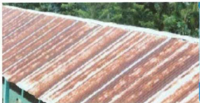
Foto1: SUSTITUCION DE LAMINAS, QUE ESTAN DESPERFECTAS.
